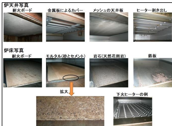
写真1 デッキオープンの炉室
